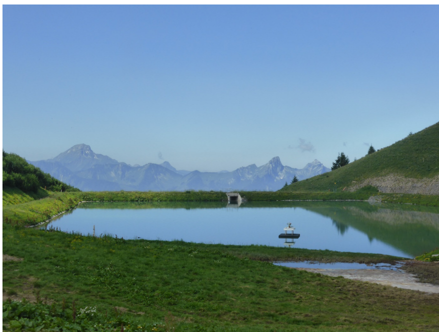
Retenue pour l'eau pour les canons à neige
